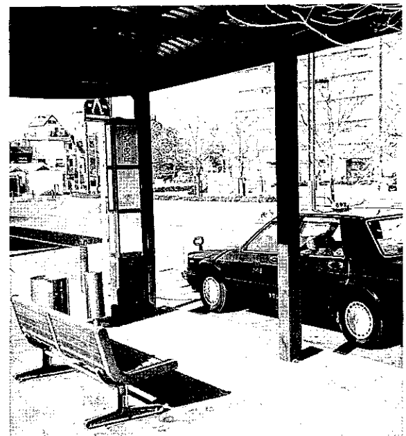
屋根とベンチのあるタクシー乗り場
